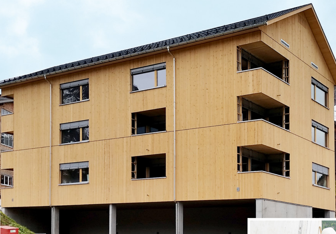
Bild unten: LH Markus Wallner bei der Grundsteinlegung in Warth am 4. August. Am 23. Dezember können die Wohnungen an die Bewohner übergeben werden.
